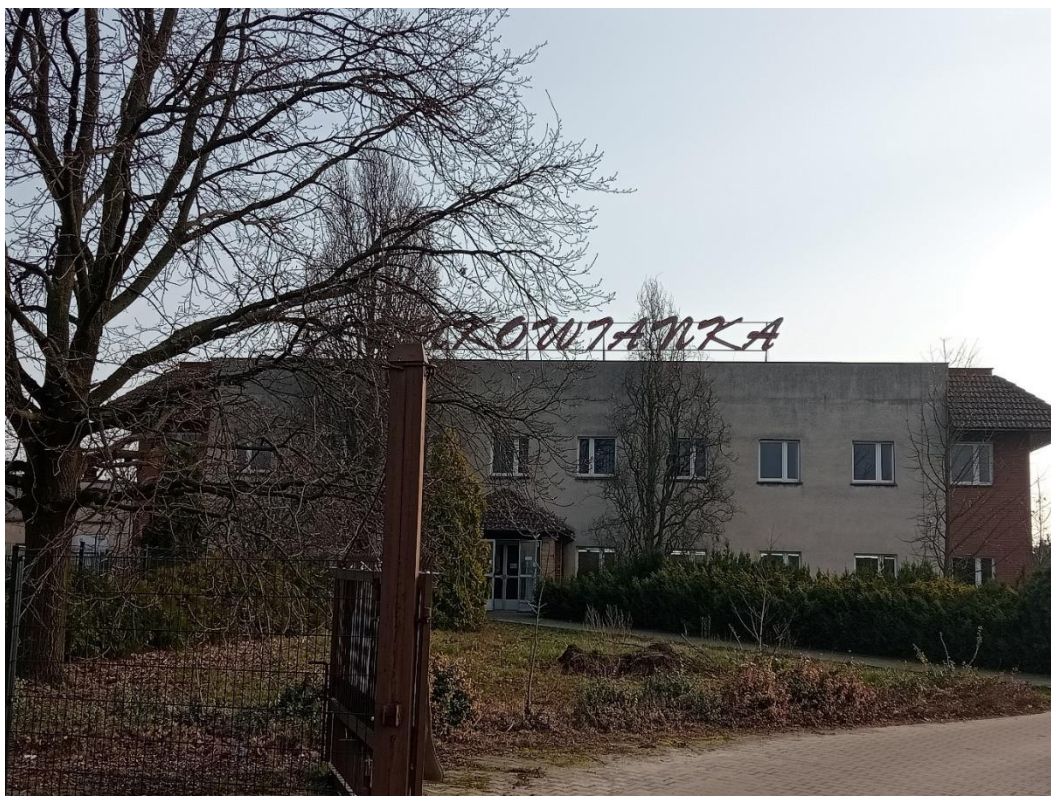
Ryc. 16 Budynek po byłej szwalni „Bukowianka”, ul. Otuska
