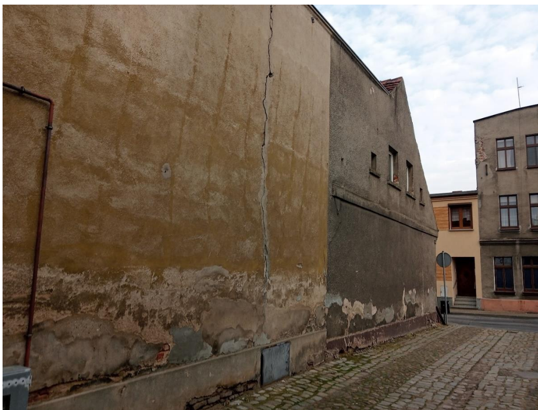
Ryc. 20 Budynki przy ul. Wąskiej
